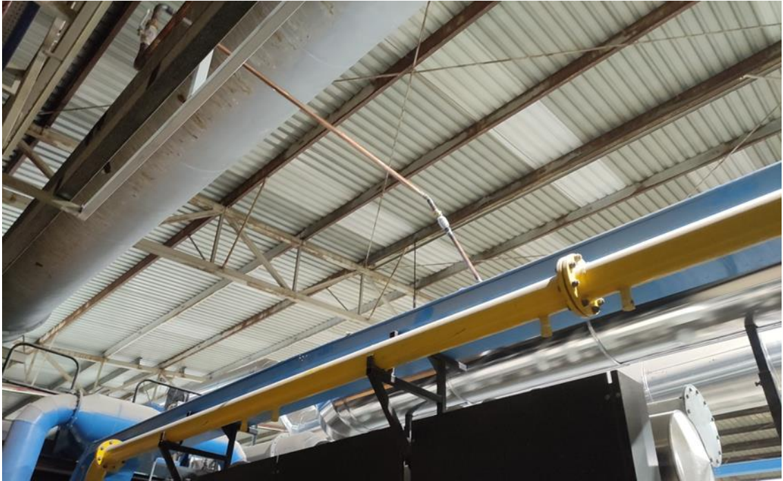
Figura 5. Inyección de oxígeno en una de las conducciones de aire de combustión.
