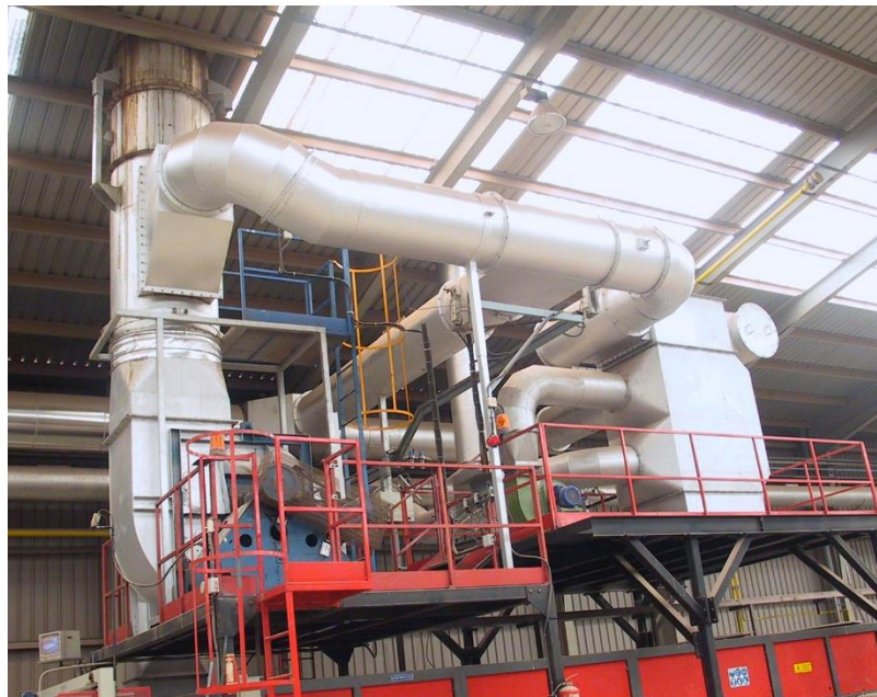
Figura 5. Intercambiador de calor humos/aire, instalado en un horno (Por cortesía de Poppi Clementino, s.p.a.).
